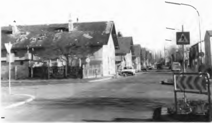
Die sogenannte VORDERE KOLONIE vor der Renovierung der Wohnhäuser
