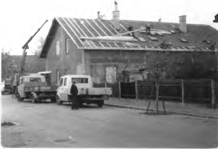
Beginn der Renovierung am 22. November 1982 mit dem durch Sturmschäden am reparaturbedürf- tigsten Wohnhaus Hartigstraße Nr. 32
