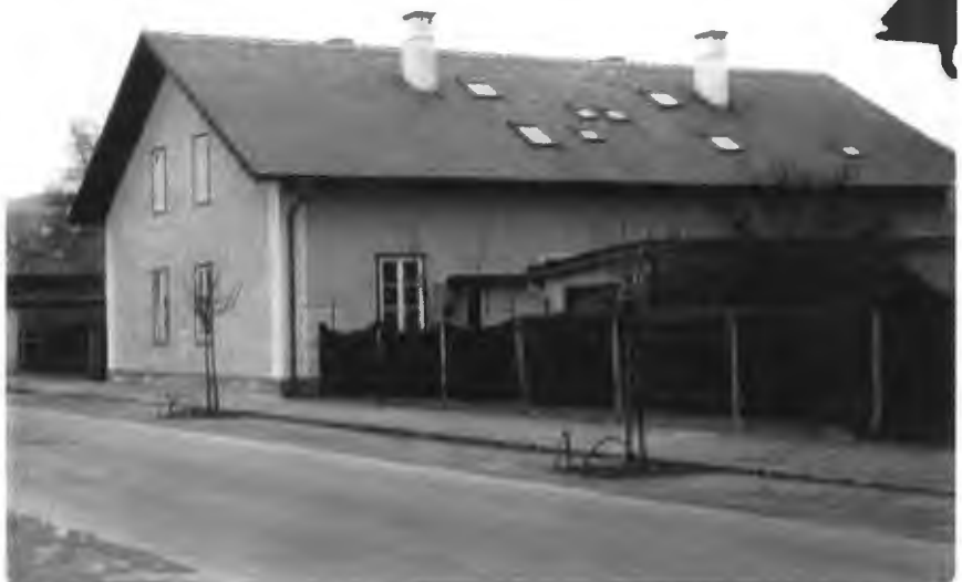
Wohnhaus Hartigstraße Nr. 32 nach der Renovierung
