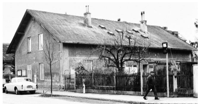
Neben den ursprünglich zwei „Guckerln“ wurden immer mehr „Entlüftungsfenster“ eingebaut.
